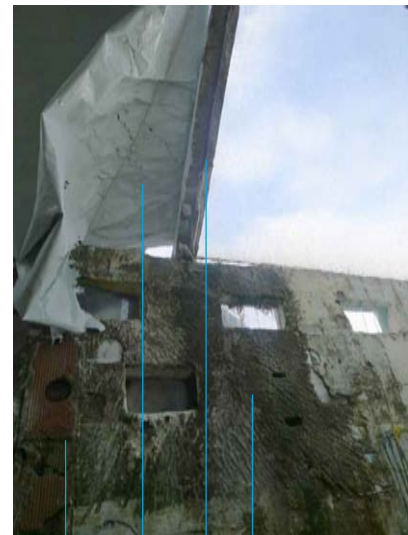
HUMIDADE CON VERDÍN EN PAREDES
