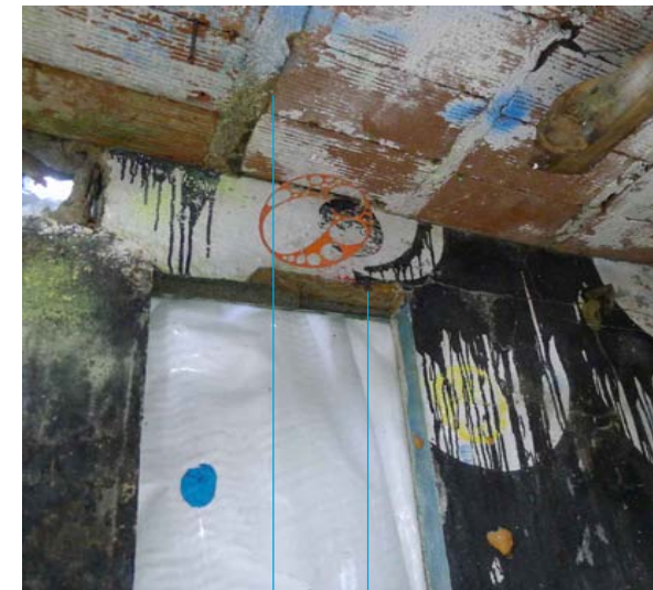
ROCA BASE CON CEMENTO GRAN CANTIDADE DE VERDÍN E HUMIDADE
